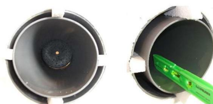
Einkerbungen für Kabel auf Positionen 8 und 10 Uhr!
